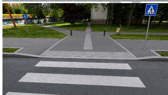
Ilustracija 7-14 Primer uređenja pešačkog prelaza sa upuštenom stazom i taktilnim površinama
