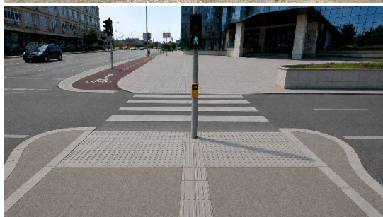
Ilustracija 7-16 Primer nivelisanja prepreka na pešačkom toku
