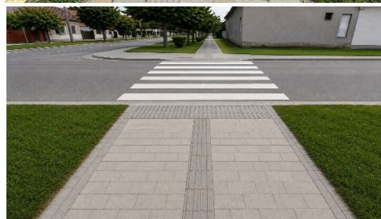
Ilustracija 7-17 Primer postavljanja taktilnih polja bezbednosti tamo gde nedostaju
